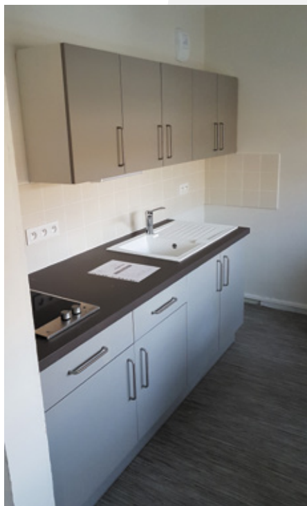
Réfection cuisine résidence Douzain
