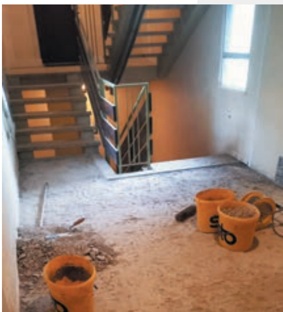
Réfection de la cage d'escaliers
