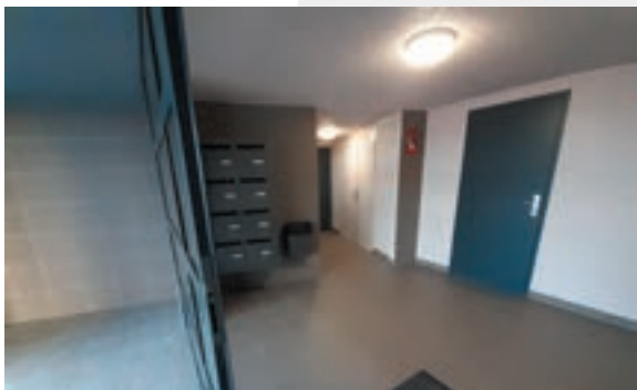
Réfection du hall d'entrée
